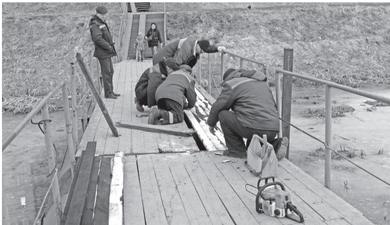
27 марта был произведен текущий ремонт понтонного пешеходного моста.
