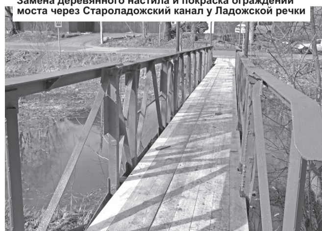
Замена деревянного настила и покраска ограждений моста через Староладожский канал у Ладожской речки
