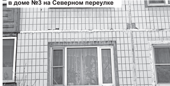
Герметизация межпанельных швов в доме №3 на Северном переулке
