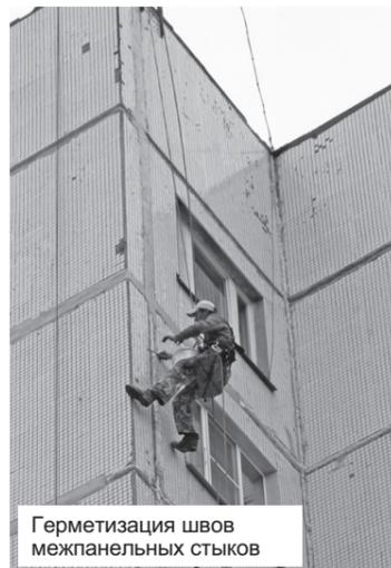
Герметизация швов межпанельных стыков
