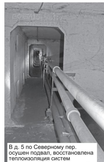
В д. 5 по Северному пер. осушен подвал, восстановлена теплоизоляция систем
