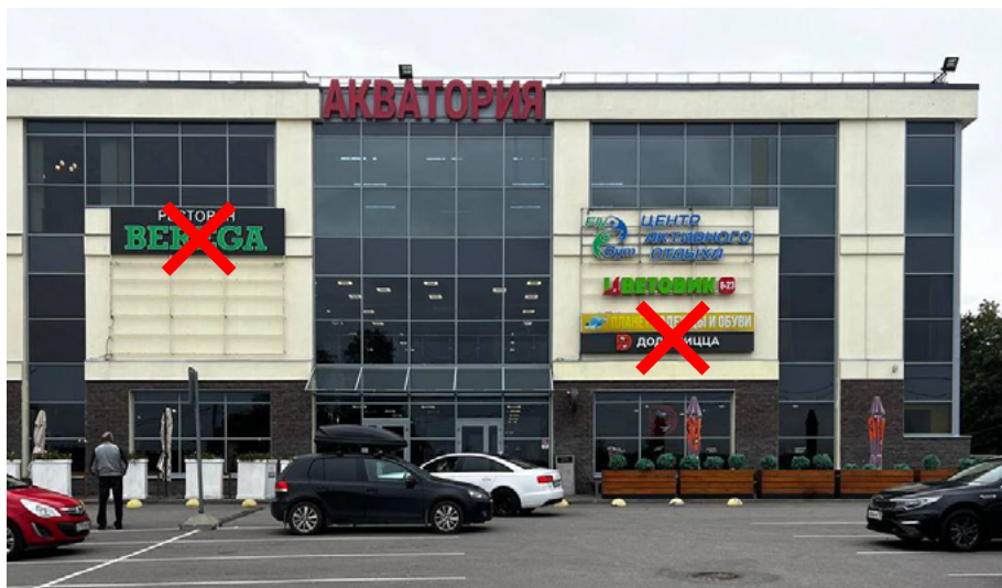
Вывески на подложке Отсутствует благоустройство входной зоны
